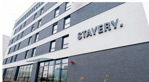
Nicht zu übersehen ist der Schriftzug an der zur Herforder Straße gelegenen Hotelfassade. Die ersten Gäste sind schon da.
