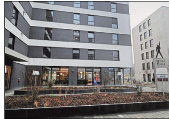
Bauherr Franz-Christoph Borchard setzt seiner Lieblingsband Queen mit der Plaza ein Denkmal.
